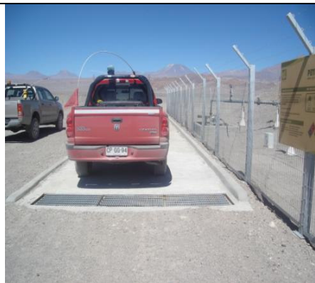
Fotografía 8. Loza de abastecimiento de petróleo con rejilla captadora de derrames.
