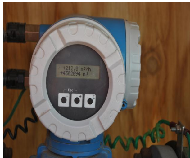
Figura 7: 8: Pozo de extracción de agua dulce para uso industrial y flujómetro certificado (Pozo Camar).
