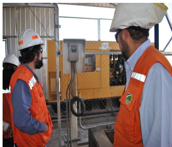
Figura 9: El pozo de extracción de agua dulce para uso industrial se encuentra abastecido de energía mediante generadores diesel, uno principal y otro de respaldo.
