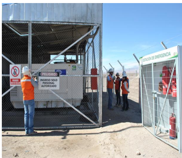
Figura 9: El pozo de extracción de agua dulce para uso industrial se encuentra abastecido de energía mediante generadores diesel, uno principal y otro de respaldo.
