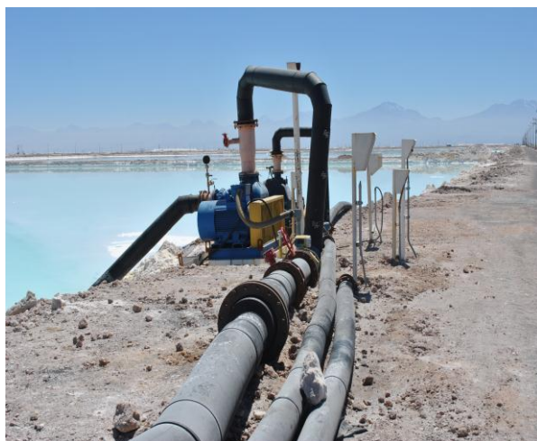
Figura 2: Flujómetro certificado en operación de bombas de extracción de salmuera, área MOP I.
