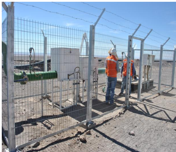
Figura 7: 8: Pozo de extracción de agua dulce para uso industrial y flujómetro certificado (Pozo Camar).
