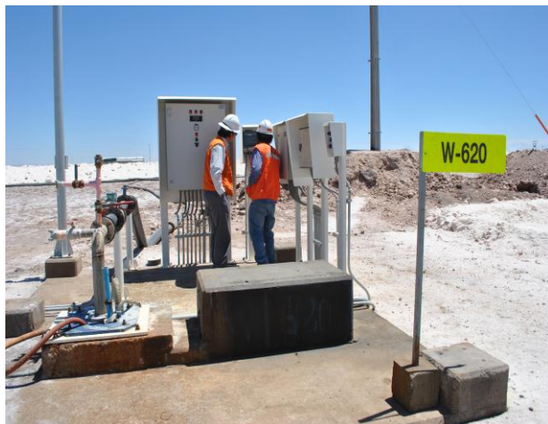
Figura 5: Pozo W-620 y flujómetro no certificado, área MOP I.
