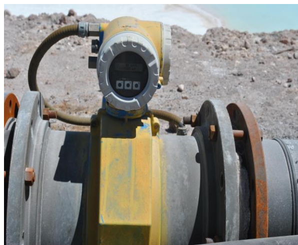
Figura 2: Flujómetro certificado en operación de bombas de extracción de salmuera, área MOP I.
