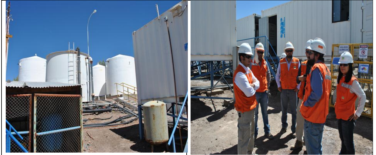
Figura 12: Sistema de plantas osmosis inversa para potabilización de agua para uso en baños y duchas en Campamento Andino.
