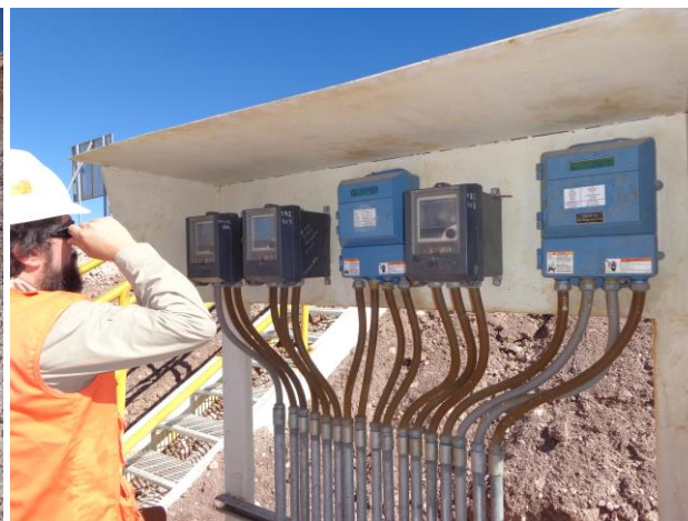
Figura 1: Poza de acumulación de salmuera PAD-5, área MOP I. Se observa las líneas de bombeo 5A y 5B, el flujómetro certificado de la línea 5A y display de los equipos con sus placas de registro.
