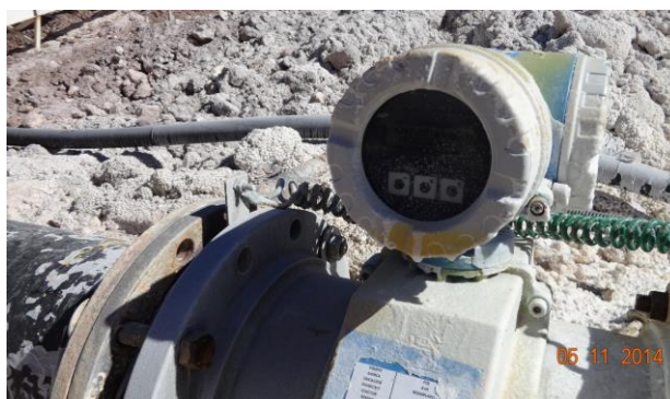
Figura 2: Piscina de acumulación de salmuera PAD-5, área MOP I. Se observa las líneas de bombeo de salmuera Norte, Centro y Sur, el flujómetro certificado de la línea Norte.
