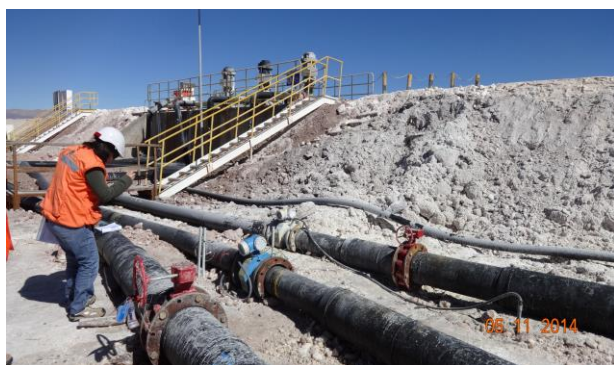
Figura 2: Piscina de acumulación de salmuera PAD-5, área MOP I. Se observa las líneas de bombeo de salmuera Norte, Centro y Sur, el flujómetro certificado de la línea Norte.
