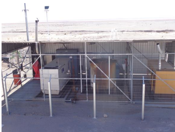
Figura 8: Vista del pozo Camar para extracción de agua fresca para uso industrial. Generadores diésel (uno operativo y uno stand by) y estanque de combustible para abastecimiento de equipos.
