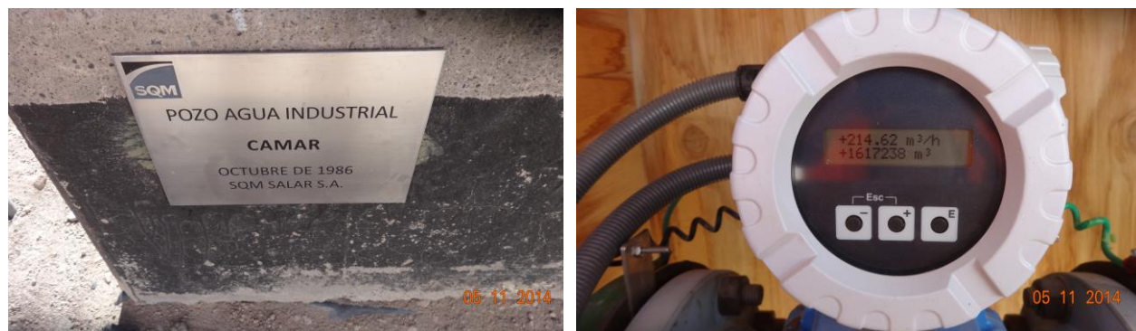
Figura 7: Pozo Camar para extracción de agua fresca para uso industrial. Vista de display de flujómetro certificado.
