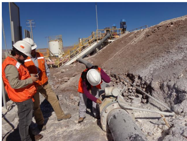
Figura 1: Poza de acumulación de salmuera PAD-5, área MOP I. Se observa las líneas de bombeo 5A y 5B, el flujómetro certificado de la línea 5A y display de los equipos con sus placas de registro.
