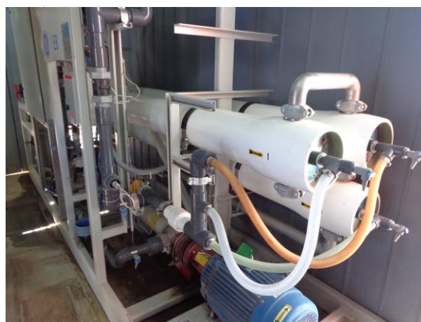
Figura 10: Sistema de plantas osmosis inversa para potabilización de agua para uso en servicios higiénicos de Campamento Andino.
