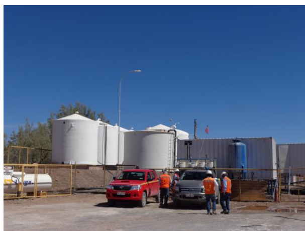
Figura 10: Sistema de plantas osmosis inversa para potabilización de agua para uso en servicios higiénicos de Campamento Andino.
