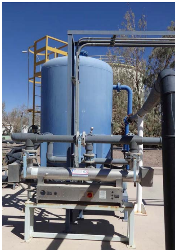
Figura 13: Pozo Socaire para extracción de agua fresca para uso industrial y flujómetro certificado.
