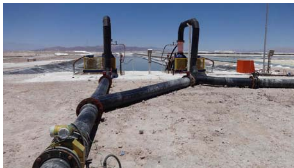
Figura 2: Flujómetro y piscina de acumulación de salmuera PDA-8A
