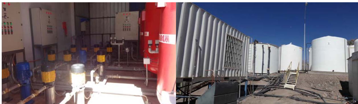
Figura 15: Sistema de plantas osmosis inversa para potabilización de agua para uso en servicios higiénicos de Campamento Andino, tanques de almacenamiento agua potable y abatidores de arsénico.
