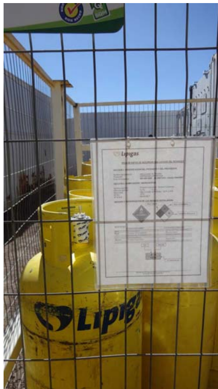
Figura 17: Almacenamiento tubos de gas licuado con Hoja de Seguridad en sector de campamento Andino.
