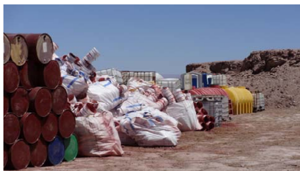
Figura 9: Manejo de residuos industriales no peligrosos en el Vertedero Cañón del Diablo. Se observa área de ingreso la al vertedero, delimitación de los residuos con tambores y señalética con el nombre de cada residuo y apilamiento de tambores a un costado de maxi sacos y bins.
