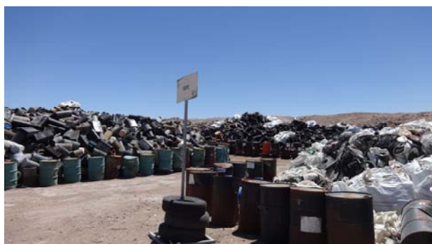
Figura 9: Manejo de residuos industriales no peligrosos en el Vertedero Cañón del Diablo. Se observa área de ingreso la al vertedero, delimitación de los residuos con tambores y señalética con el nombre de cada residuo y apilamiento de tambores a un costado de maxi sacos y bins.
